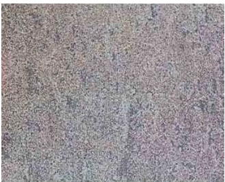
Condicion A Blasted to Sa 1
