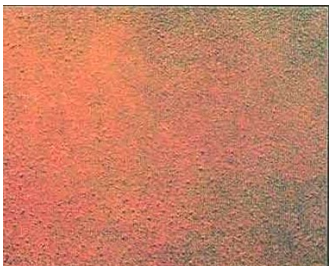
Condicion C Blasted to Sa 1
